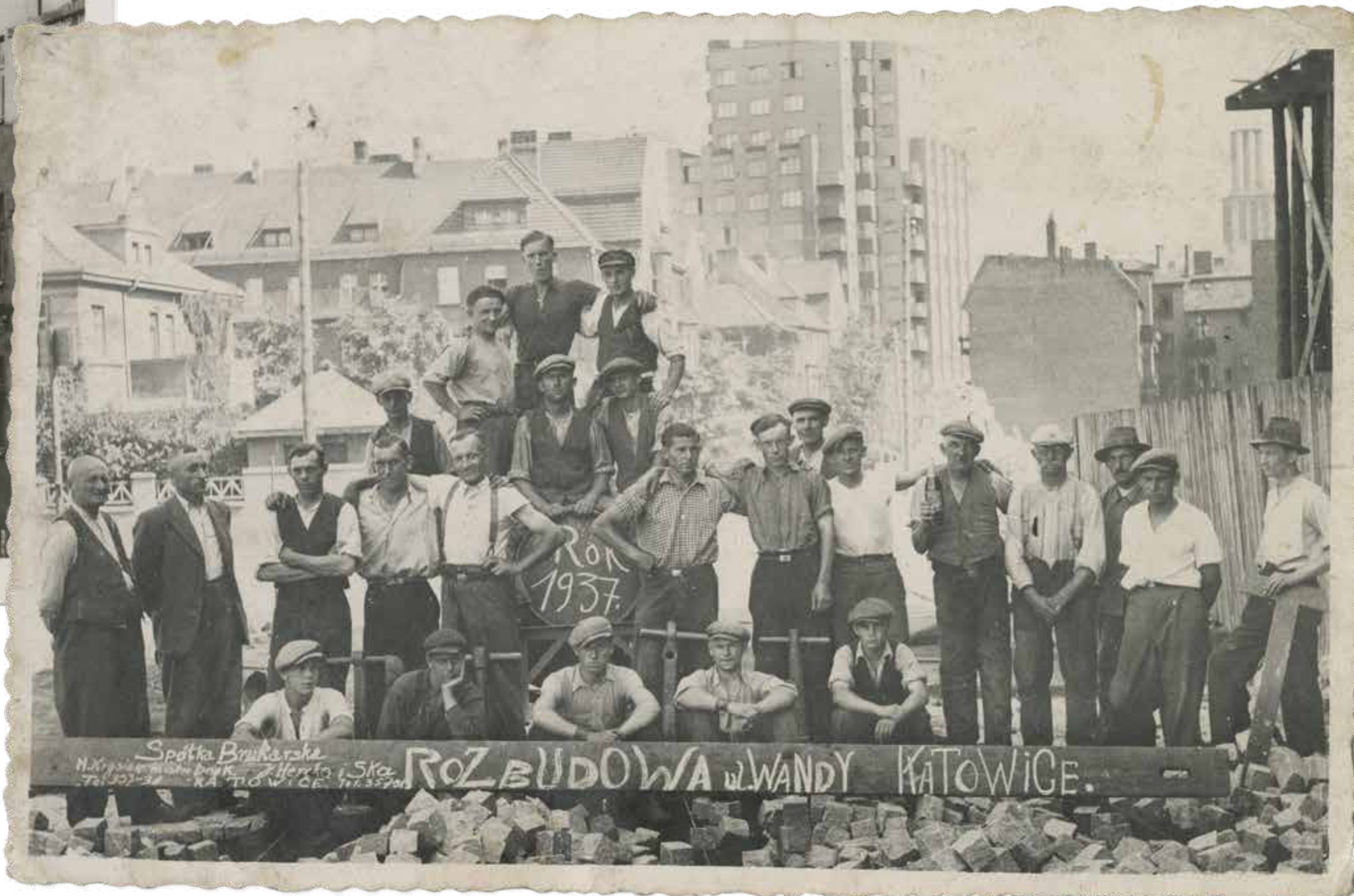
› GRUPA ROBOTNIKÓW PRZY ROZBUDOWIE UL. WANDY (W TLE WIDOCZNY DRAPACZ CHMUR). FOTOGRAFIA NIEZNANEGO AUTORA, 1937. MUZEUM HISTORII KATOWIC.
